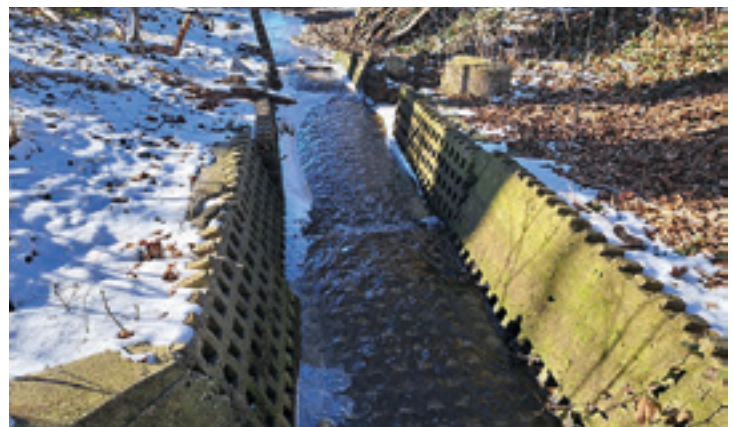
Ein mit Rasengittersteinen verbautes Gewässer. Die Platten sind instabil und im Hintergrund kann man sehen, wie sie bereits ins Gewässer fallen. Zurück bleibt ein ungeschütztes Ufer.
